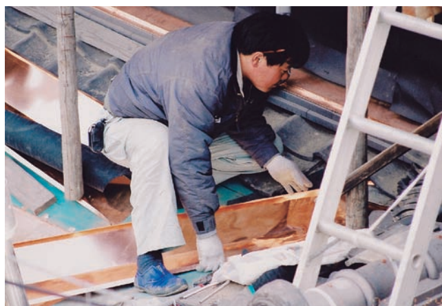
写真6 長屋を銅版で改修工事
